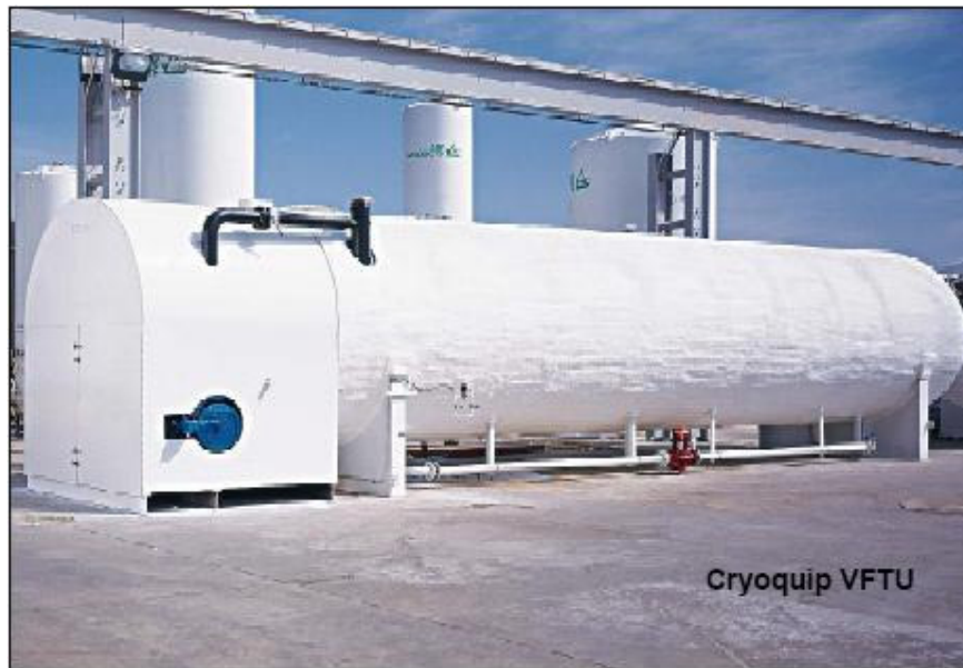
Figura 3.4 - Vaporizador do tipo banho de água (“water bath”). (Franklin, 2006)
